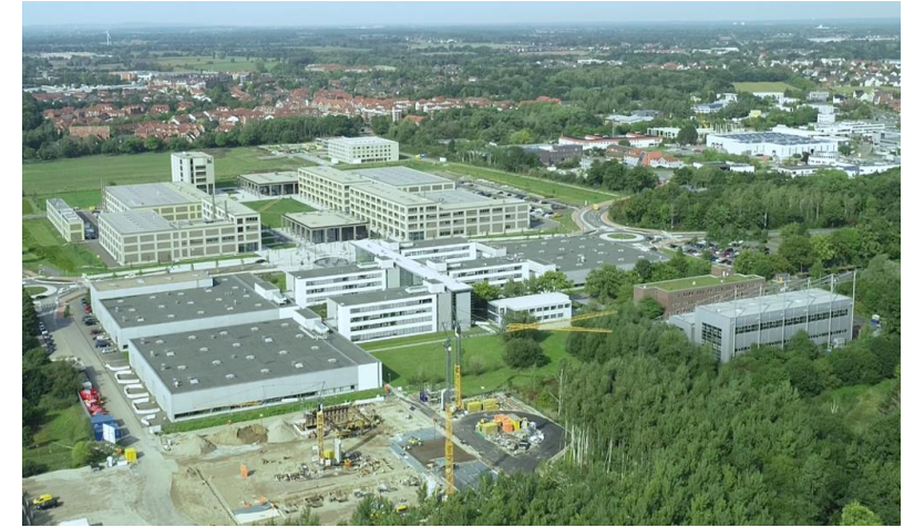
Campus Maschinenbau Garbsen
